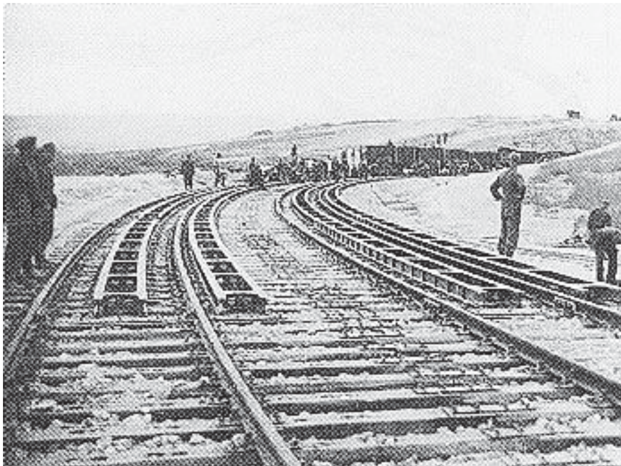
Рис. 6 – Устройство огневой позиции железнодорожного орудия «Дора», 1942 г. Крым
