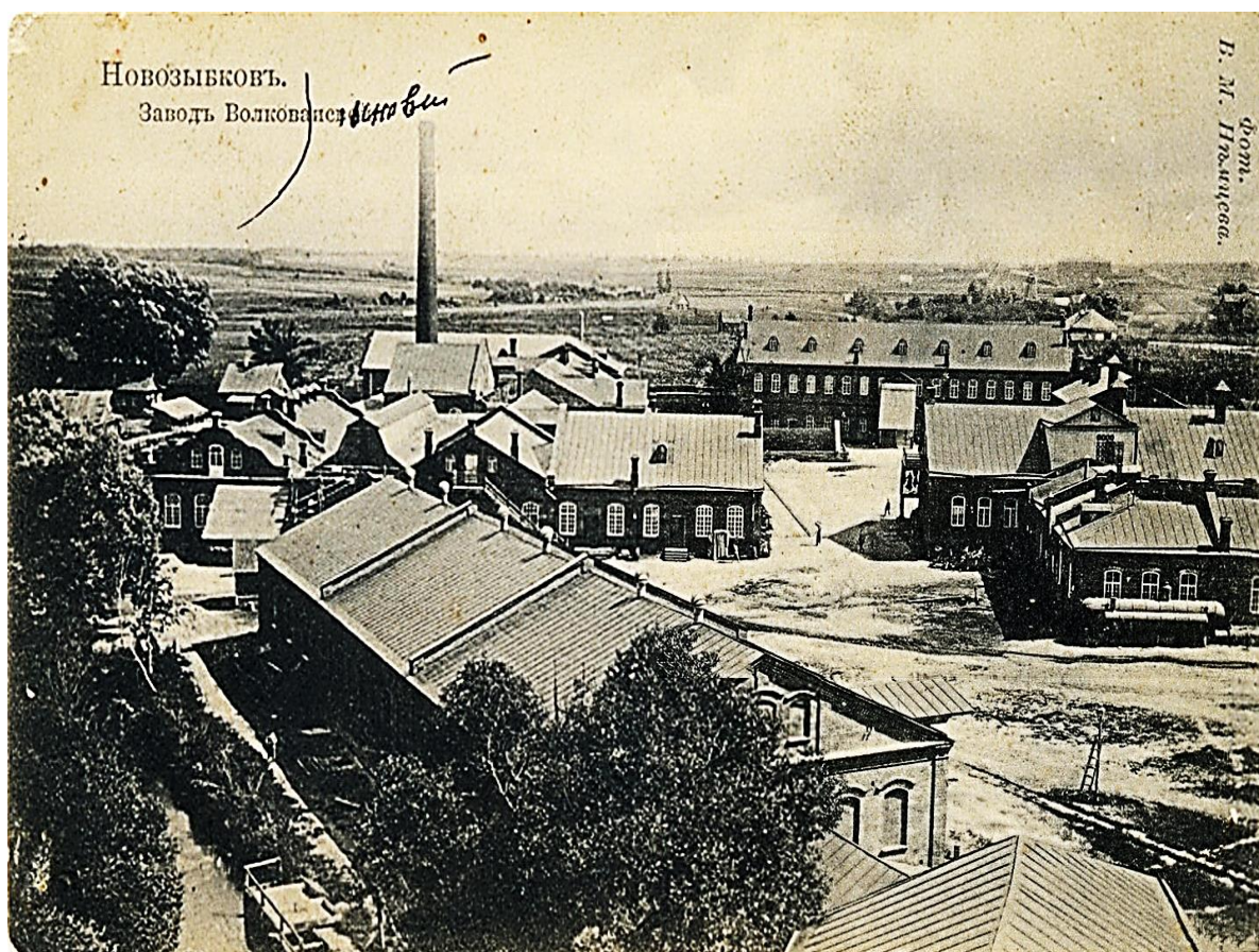
Г. Новозыбков. Завод М.М. Волкова Начало XX в.
